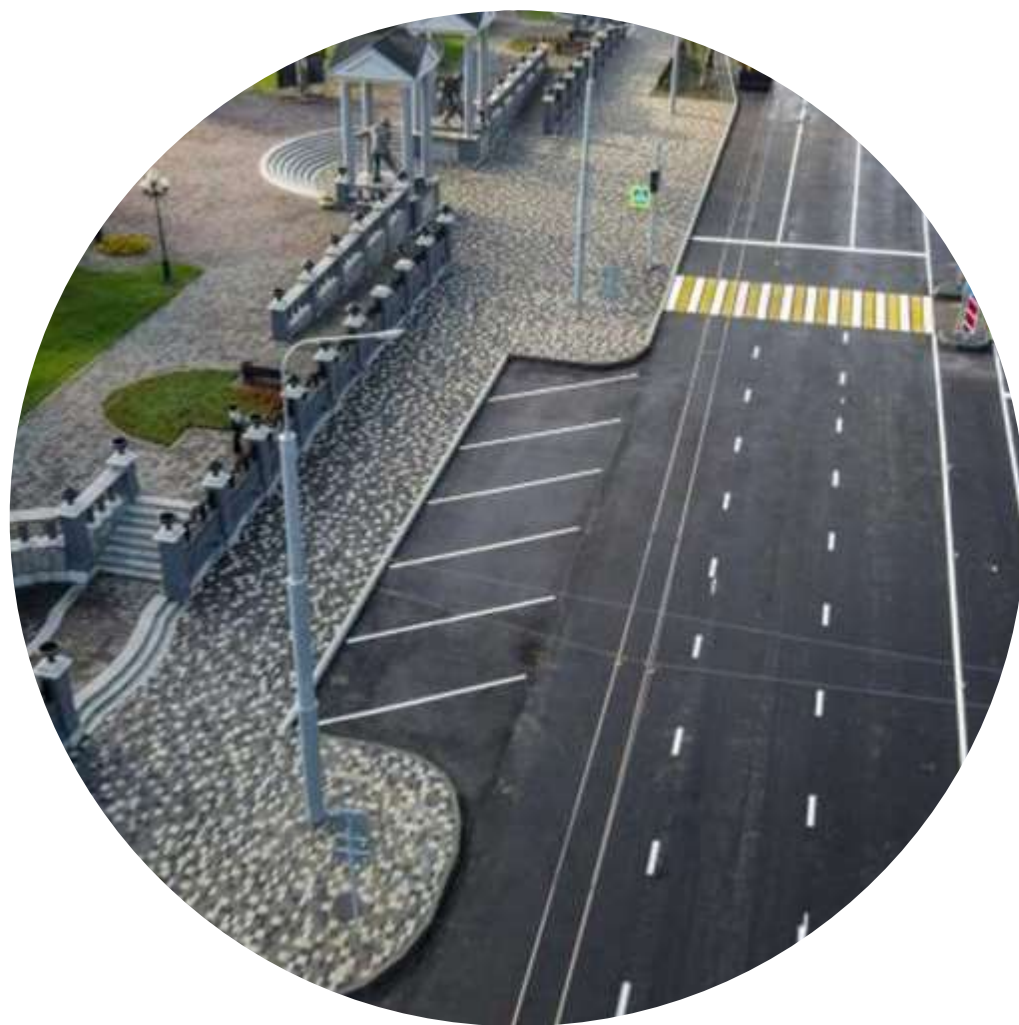
Реконструкция проспекта Металлургов в г. Новокузнецке (2020г.)
