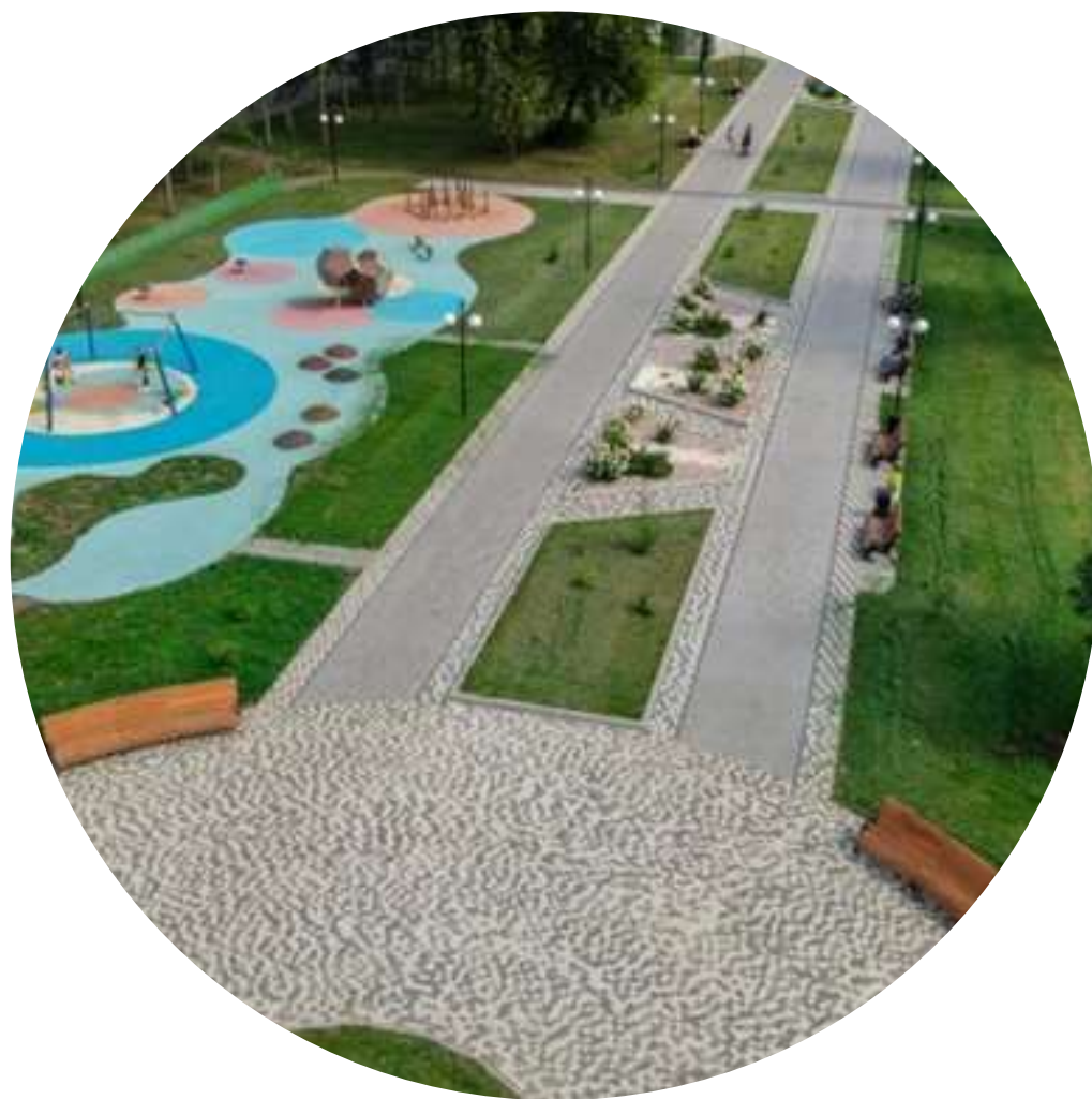
Ремонт набережной р. Томь вдоль ул. Назарова в Кировском районе г. Кемерово (2018 г.)
