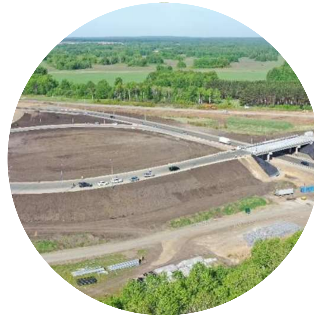
Строительство обхода г. Мариинска (2020 г.)
