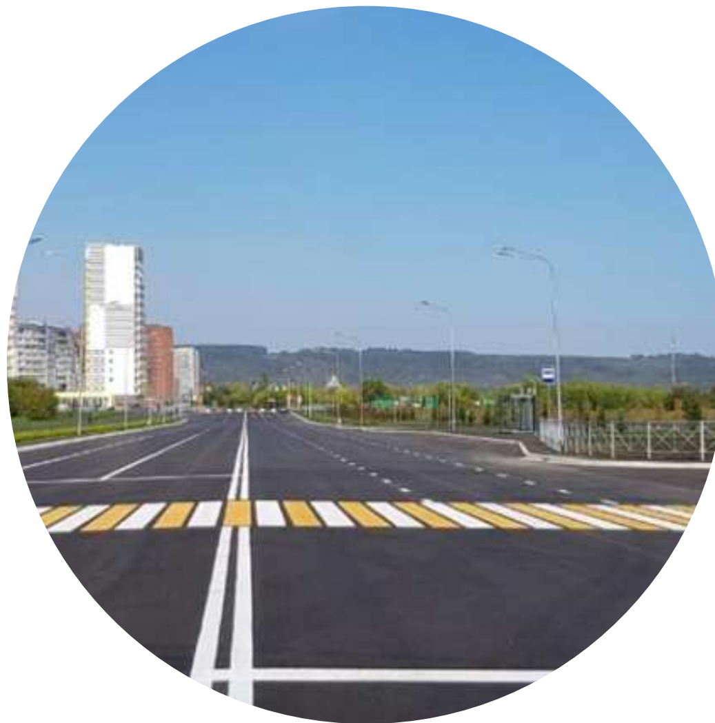
Строительство пр. Комсомольский на участке от пр. Ленина до пр. Химиков в г. Кемерово (2020 г.)
