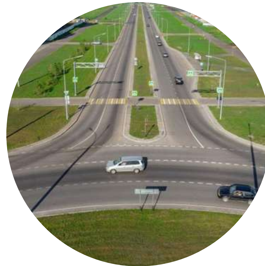
Строительство пр. Химиков от пр. Комсомольского (2019 г.)
